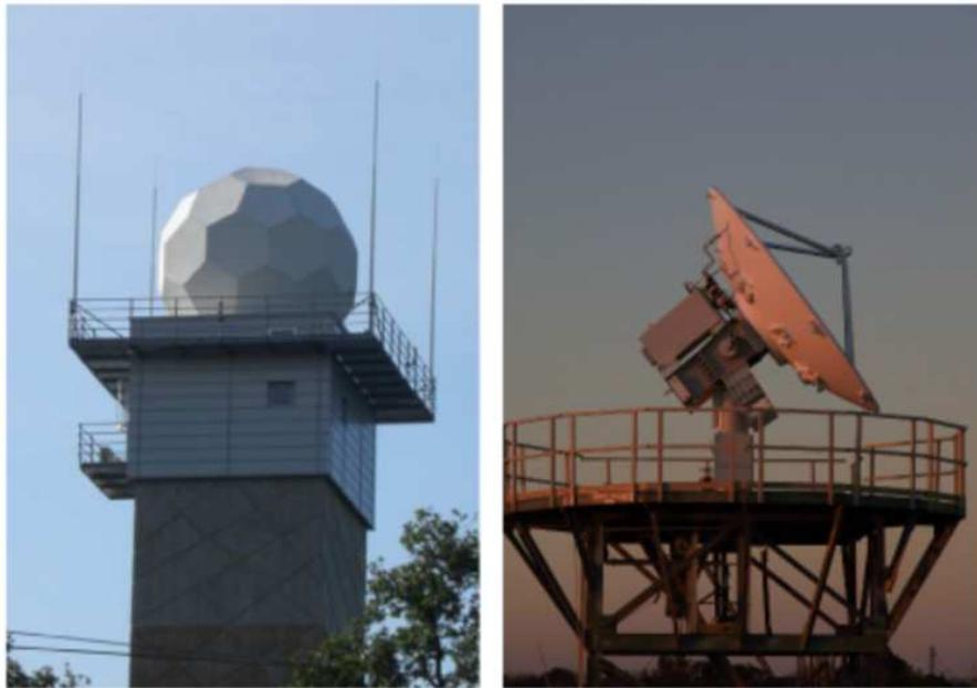
**Abbildung 3:** Links: Wetterradarsystem Offenthal auf seinem circa 45 Meter hohen Betonturm. Das eigentliche Radarsystem wird durch das Radom vor Witterungseinflüssen geschützt. Weiterhin sind die vier Blitzschutzstangen zu sehen. Rechts: Ein Wetterradarsystem ohne schützende Radarkuppel. Die in Azimut und Elevation bewegliche Antenne ist, zusammen mit den notwendigen Gegengewichten, auf einem Standfuß montiert. Hinter dem Radarreflektor ist der Empfänger angebracht.
